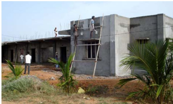
Travaux de finitions du centre de formation déjà en activité.
